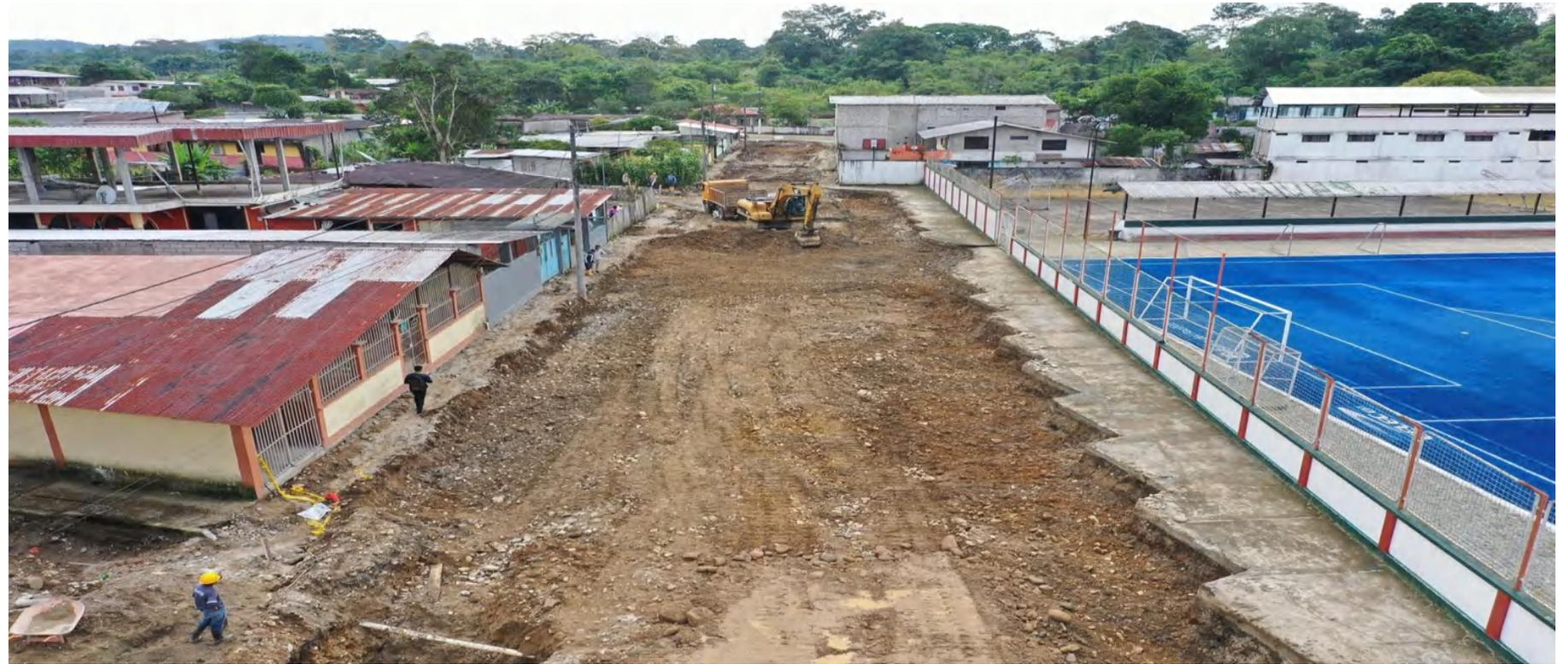
Con seguridad se realiza el proyecto de asfalto de la calle Oriente en el barrio Piedra Grande. En la obra se realiza el cambio de la red de distribución de agua potable, así como, la construcción de bordillos. El proyecto contempla 310 metros de longitud de asfalto, desde la avenida Rocafuerte hasta la Troncal Amazónica. Otros trabajos son: cambio de suelo, alcantarillado pluvial y aceras.
