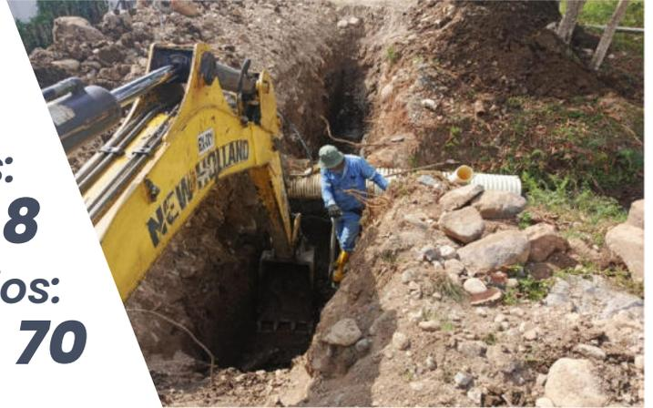
La obra pública que comprende la **REPARACIÓN DE ACOMETIDAS SANITARIAS, INSTALACIÓN DE TUBERÍA PARA LA CONDUCCIÓN DE AGUAS LLUVIAS Y CONSTRUCCIÓN DE RED TERCIARIA** ha sido ejecutada por la administración municipal con el objetivo de mejorar las condiciones del sistema de saneamiento básico en sectores del cantón Archidona. Estas intervenciones son fundamentales para garantizar un servicio eficiente y seguro que responda a las necesidades reales de la población.
