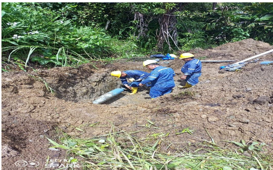
Participación en la inspección del proceso de colocación de tuberías del sistema de agua potable en la parroquia de Cotundo
