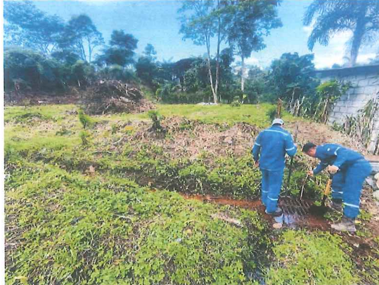
Ilustración 2: Limpieza de las rejillas.
