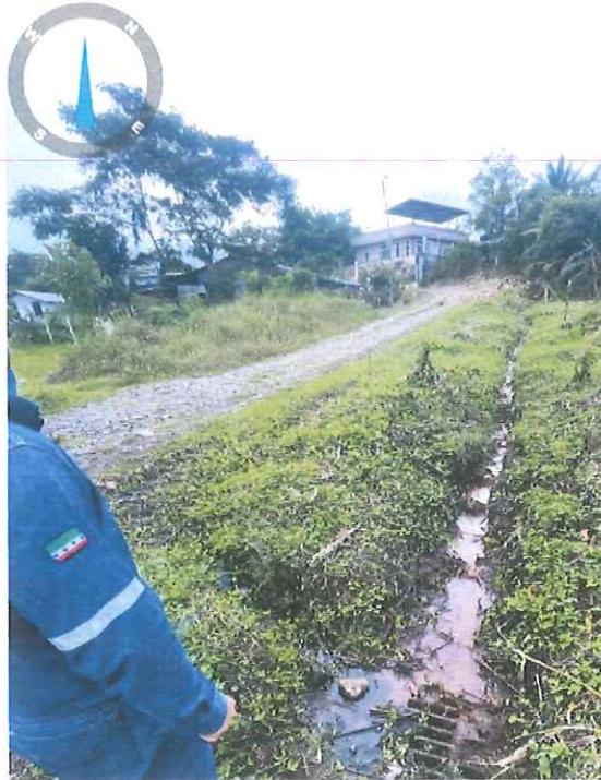
Ilustración 4: Relastrado de la vía deteriorada.
