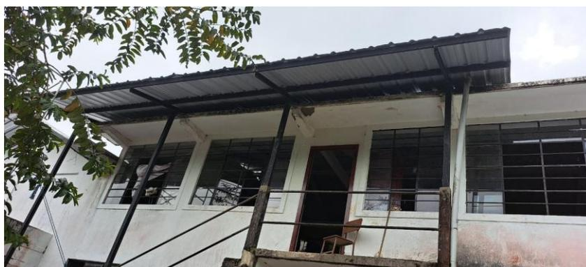
Además se realizó la limpieza con hidrolavadora de las gradas y paredes más afectadas por moho negro, se realizó también masillado de filos y de las gradas, se levantó paredes, se fundió un contrapiso y una columna para que se pueda colocar posteriormente un portón.
