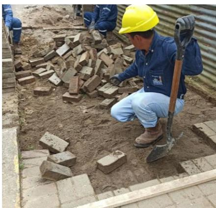
El mantenimiento de aceras se refiere a la reposición del nivel en la superficie de la acera debido al hundimiento o levantamiento del adoquín.
