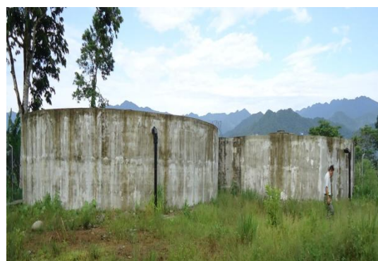
Foto Tanques de distribución sin uso-Urbano
